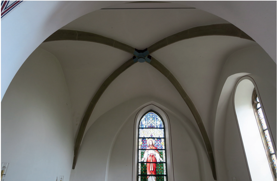
Abb. 6: Evangelische Kirche in Roigheim, Blick in das Chorgewölbe.
