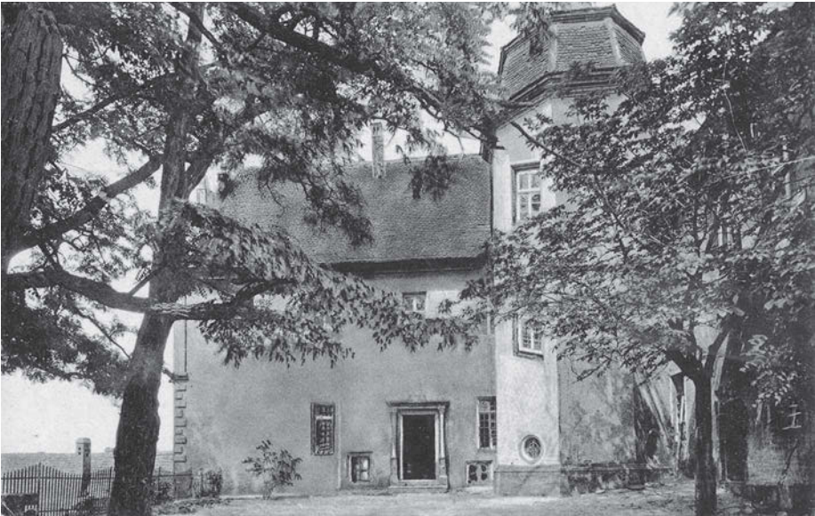
Südseite des oberen Greckenschlosses mit dem 1945 zerstörten Treppenturm, der Spindel oder auch Schnecke; um 1920 (StadtA Bad Friedrichshall, DS Koch_546)
