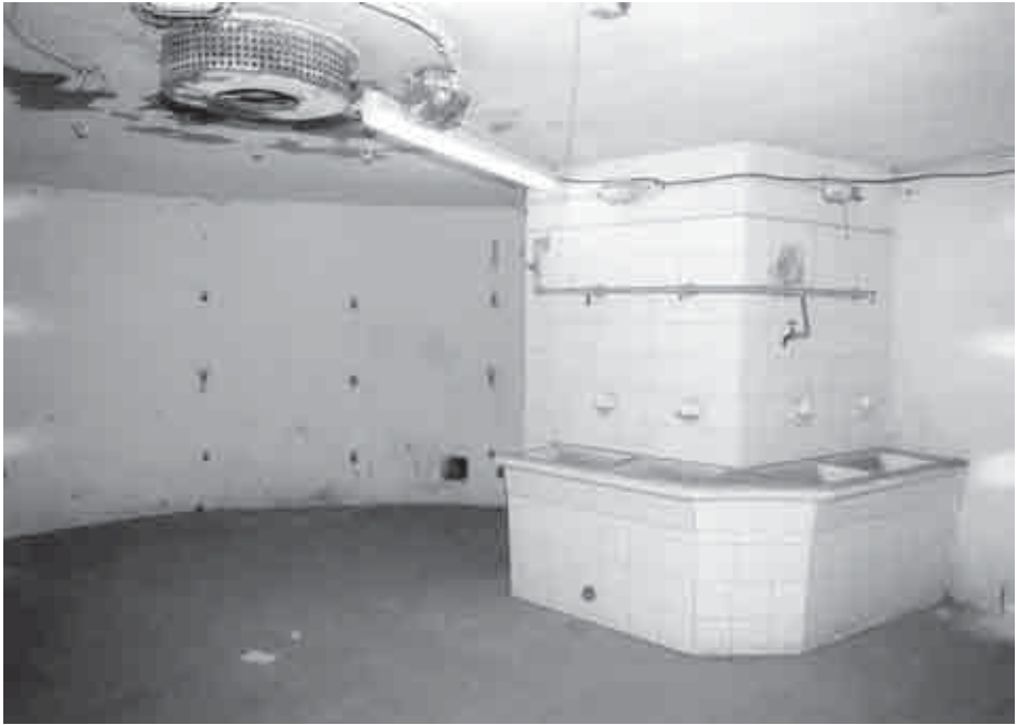
Mannschaftsraum mit Waschgelegenheit; Zustand 2000.
