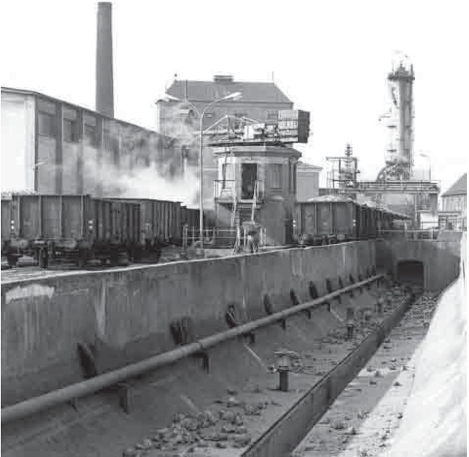
*Die Zuckerrüben wurden auf dem Gelände der Zuckerfabrik durch Druckwasserstrahl aus den Waggons in Transportgruben geschwemmt.*
