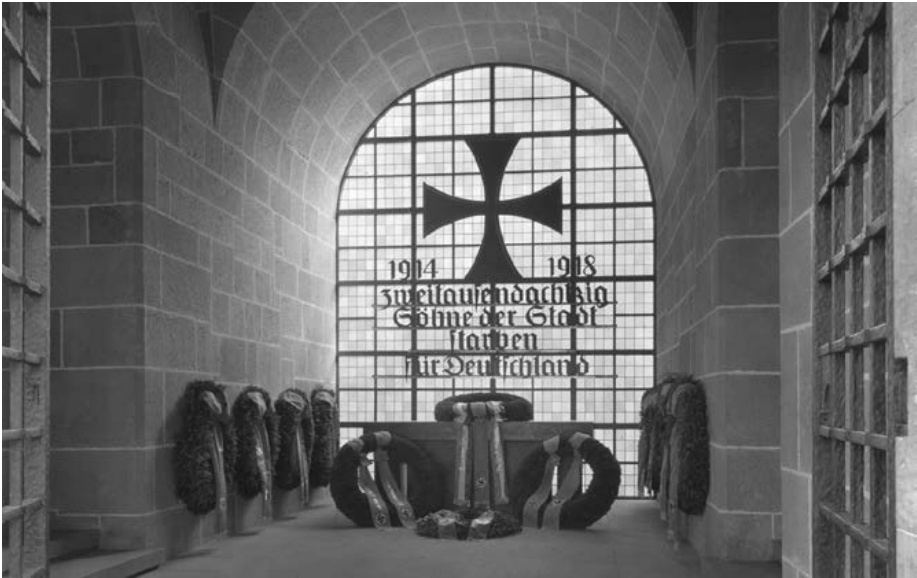
Das „Ehrenmal“ im Hafenmarktturm nach seiner Fertigstellung; 1936. (bpk / Willi Moegle)
