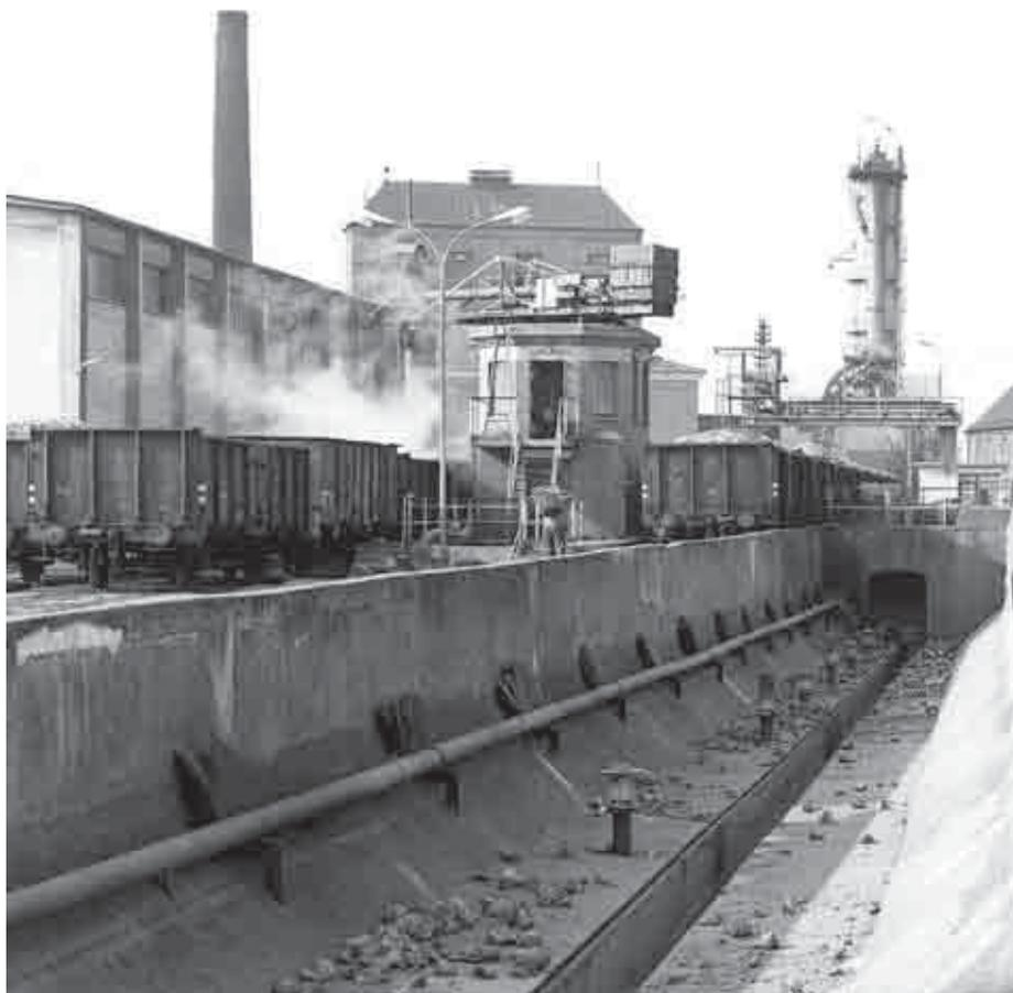
*Die Zuckerrüben wurden auf dem Gelände der Zuckerfabrik durch Druckwasserstrahl aus den Waggons in Transportgruben geschwemmt.*
